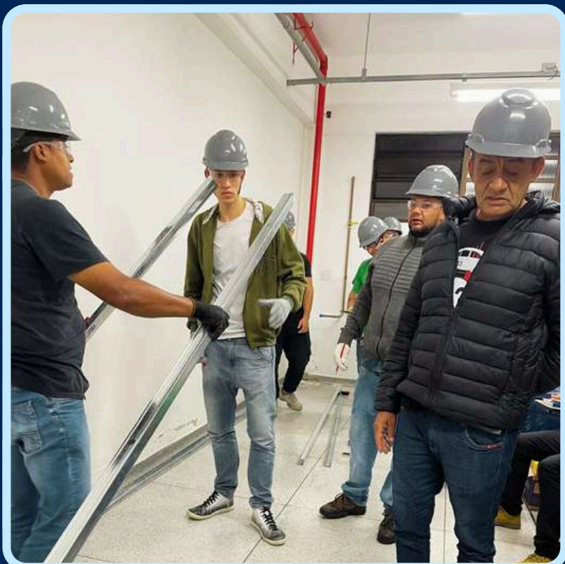
Instalação de Drywall
